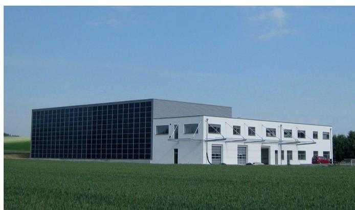
cámara de refrigeración especial para los productos farmacéuticos sensibles a la temperatura, con más de 100 espacios para bodega. Asper II está equipado con un sistema fotovoltaico en las fachadas sur y oeste con 429 paneles sobre una superficie de 721 m<sup>2</sup> y una capacidad nominal de 100.345 kWp.
